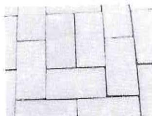
Calçadas externas contornando a edificação e calçadas da área de lazer em piso de concreto intertravado, tipo paver. Modelo tipo platô, 19,9X10X4cm. Cor: Natural/ Cinza.
